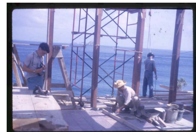
Chantier de la guest house, 1963 Crédit photo: Fondation Rockefeller
