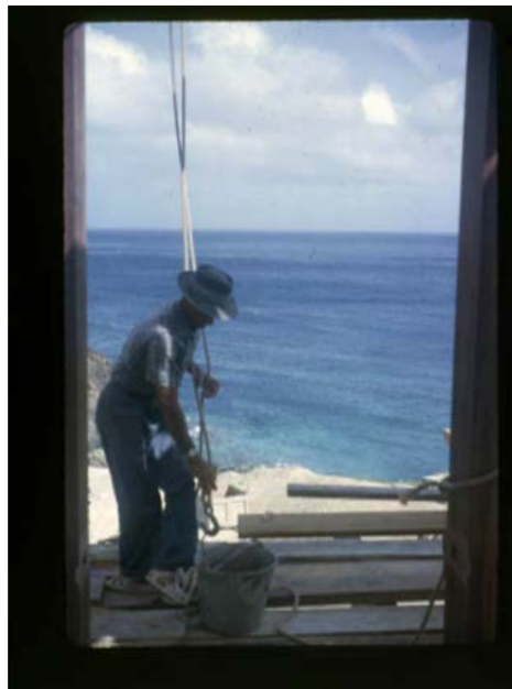
Photos du chantier de la guest house, 1963 Crédit photo: Fondation Rockefeller
